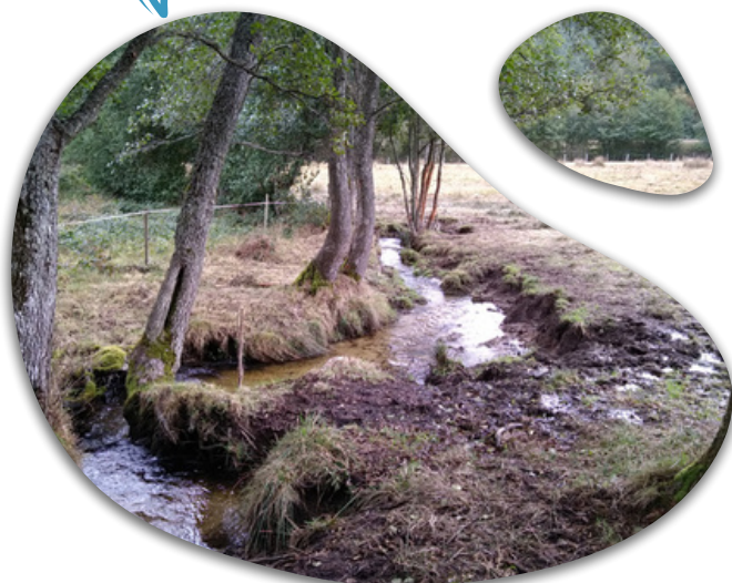
Piétinement sur la Durolle avant travaux
