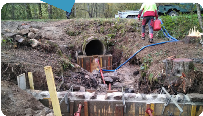
Aménagement d'une buse sur le Charlotier
