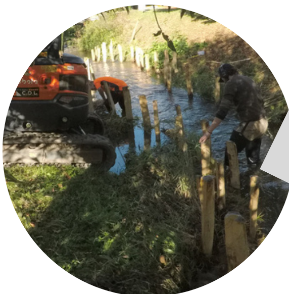
Mise en place de génie écologique (boudin d'hélophyte) sur le Vauziron
