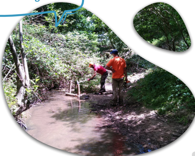
Travaux de restauration sur le Malgoutte
