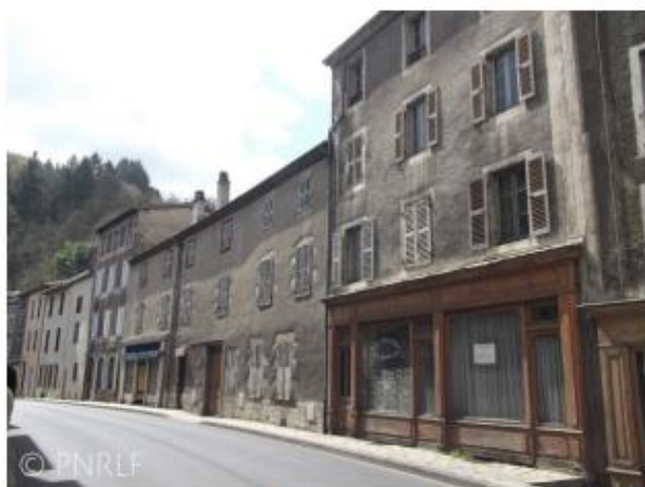
Îlot avant travaux.
