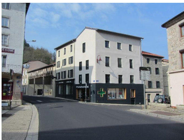
Îlot après travaux
