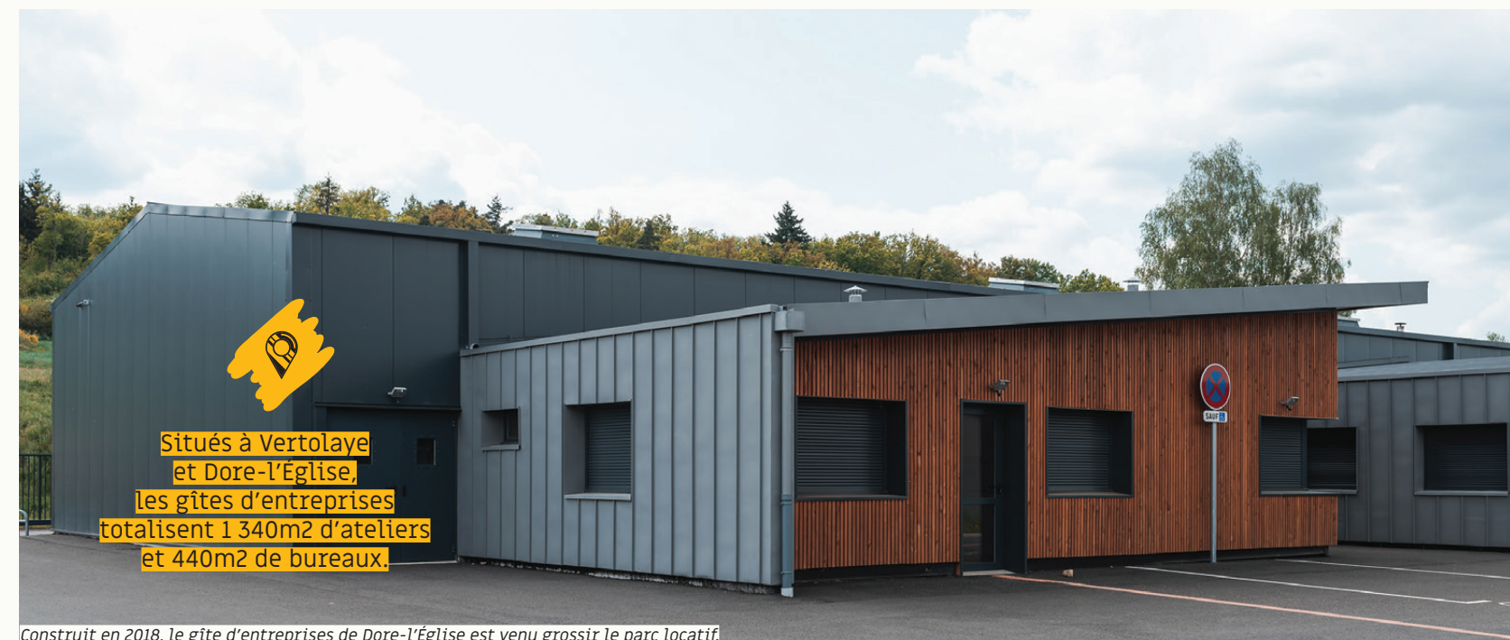
Construit en 2018, le gîte d'entreprises de Dore-l'Eglise est venu grossir le parc locatif.
