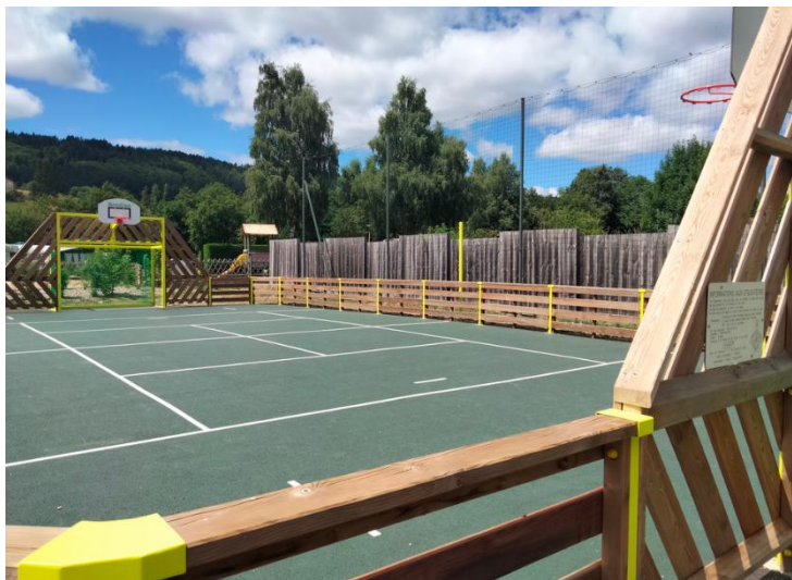
Figure 37. Terrain de basket-ball rénové en 2024 à proximité du plan d'eau de Saint-Anthème (photo : Laval F., 22 juillet 2025)
