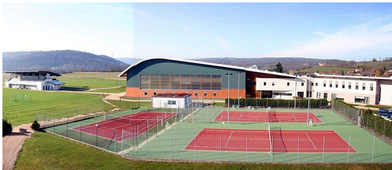
Figure 36. Vue sur le centre sportif H3s d'Hauteville (Ain), une structure complète et intégrée
