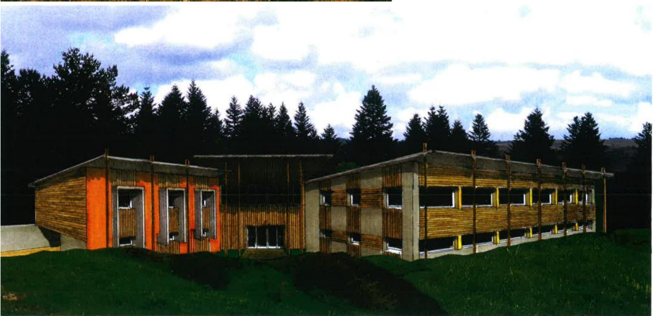
vue sur entrée
