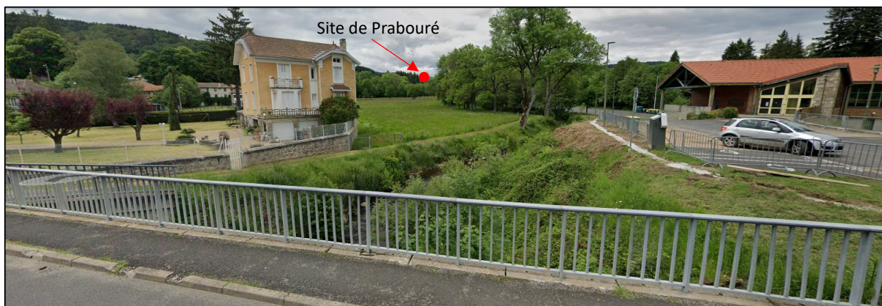
1/ Vue cadrée depuis le pont sur l'Ance en sortie ouest de Saint-Anthème (RD996) (Source : Google Maps)
