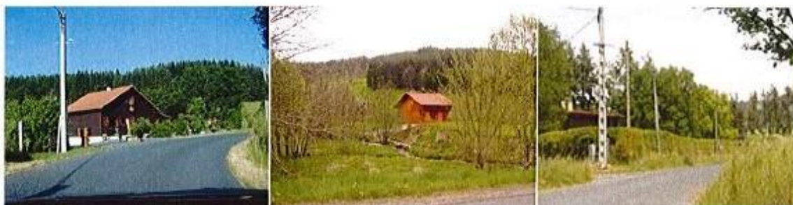
Des constructions bois de type « Chalet » savoyard
