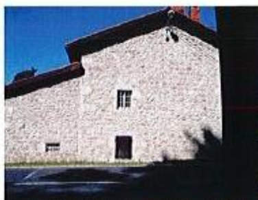
Joints lissés et sablés, effet d'unité
