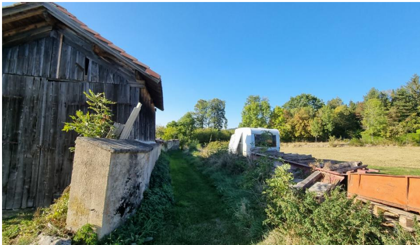
Vue sur le chemin ouest et l'arrière du tènement, depuis la rue des Pradoux
