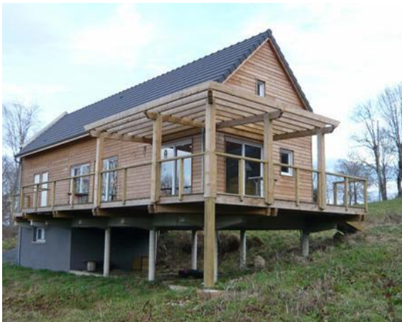
Maison individuelle – Ceysnat, Source : CAUE d'Auvergne
