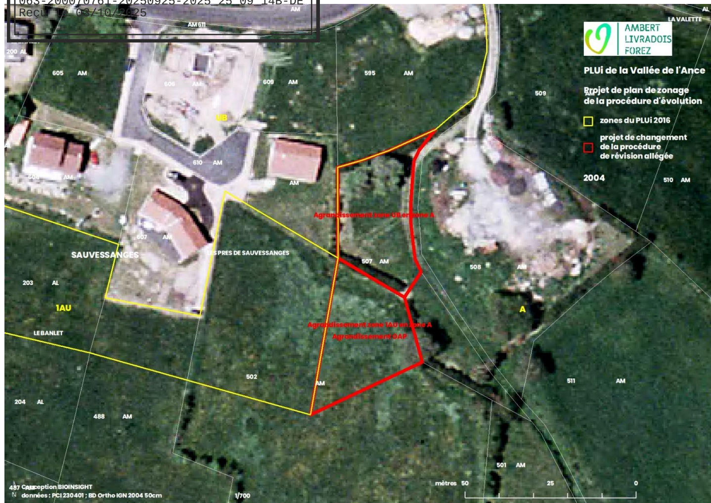
Sauvevassanges : Les Prés : 2004 : traces d'humidité en aval de la parcelle AM5007
