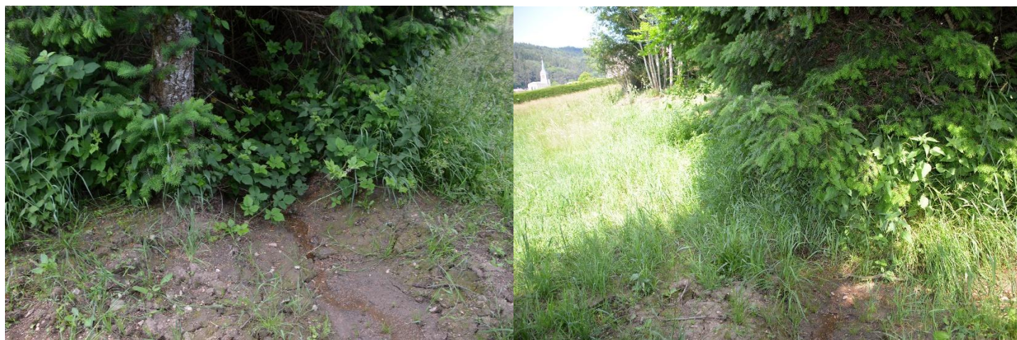
Les Prés : limite entre les parcelles AM507 et AM502 : écoulement/fossé (photos 230615-188-208 Luc Laurent)
