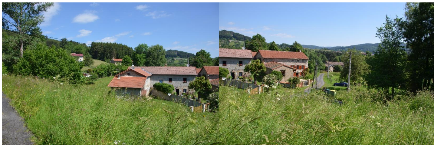
Mascortel : entrée de la partie nord du hameau (parcelles C526 et C525) : surface ouverte non imperméabilisée (photos 230614-106-108 Luc Laurent)
