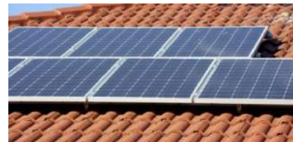
Panneaux posés parallèlement à la pente du toit
