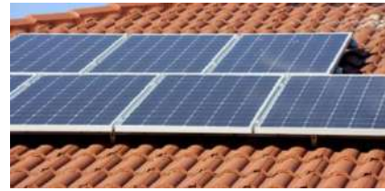
Panneaux posés parallèlement
