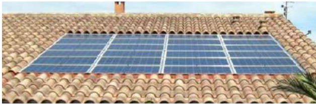
Panneaux encastrés à la pente du toit
