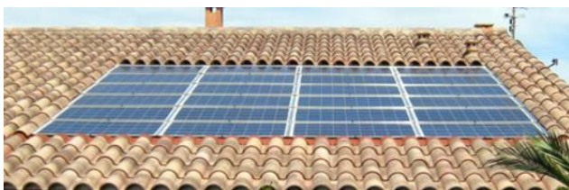
Panneaux encastrés à la pente du toit
