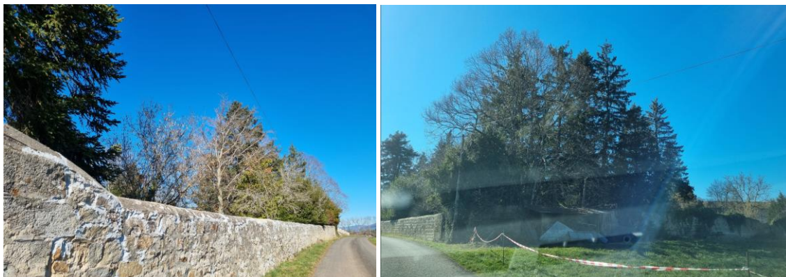
Le parc arboré concerné : vues depuis le chemin rural
