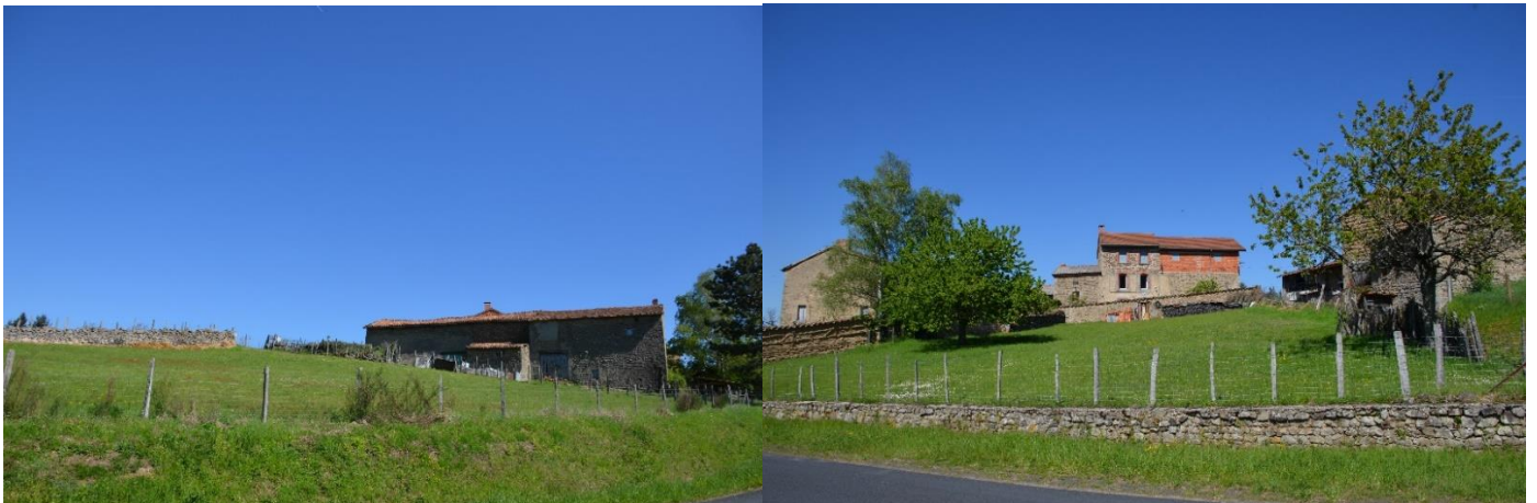
Entrée nord du village de Laire depuis la RD225 : parcelles ZB343 et ZB581 puis parcelle ZB340 avec ouvertures (photos Luc Laurent)
