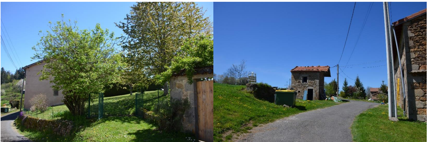
Fredonnet côté occidental : ouvertures : parcelles ZK197 (à gauche) et parcelles ZK134 et ZK 135 (photos Luc Laurent)
