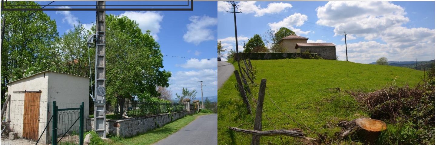
Les Gouttes : parcelle ZM14 avec des bâtis anciens et parcelle ZM15 (photos Luc Laurent)
