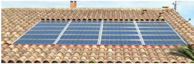
Panneaux encastrés à la pente du toit
