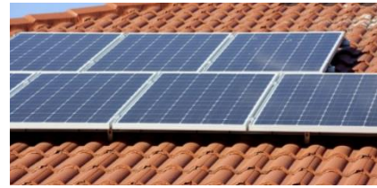
Panneaux posés parallèlement
