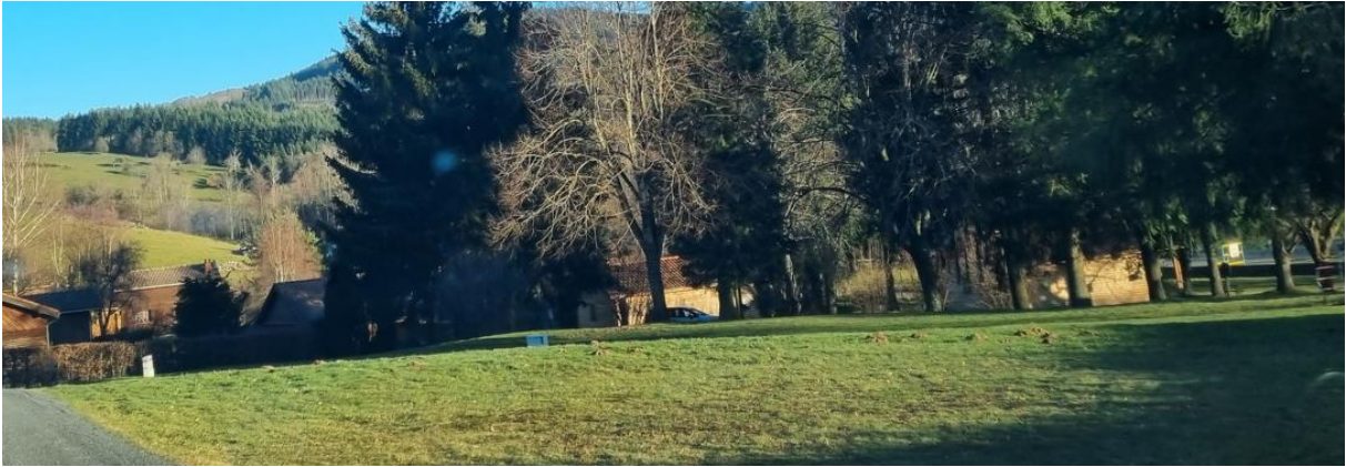
Vue sur le terrain suite à la démolition des chalets (prise depuis le chemin de la Barge) : photographie Réalités 2023
