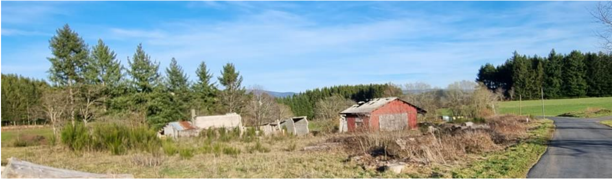
Vue depuis la RD sur les bâtiments de la scierie, après sinistre
