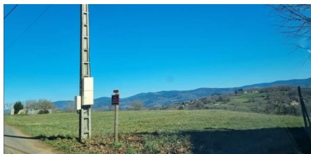
Vue depuis la voie de desserte sur le terrain, en limite de la parcelle n°159/158
