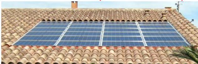
Panneaux encastrés parallèle à la pente de toit
