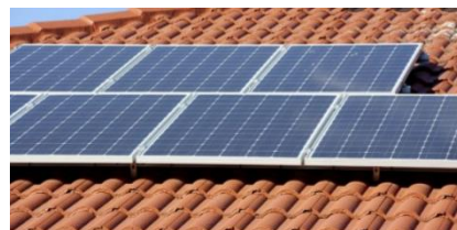
Panneaux posés parallèlement
