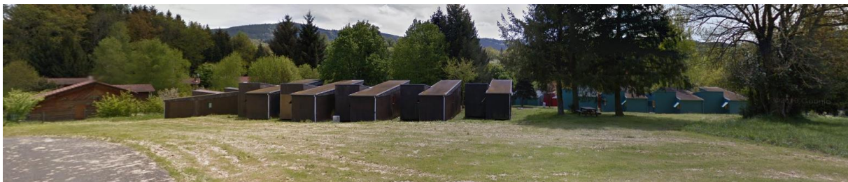
Vue sur les chalets aujourd'hui détruits (en marron, les chalets en arrière plans étant toujours existants : en bleu) : photographie google maps 2013
