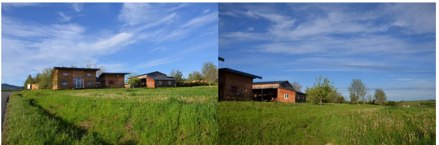
Les Gouttelles : zone Ue agrandie dans zone A : partie de la parcelle ZN315 (photos Luc laurent)
