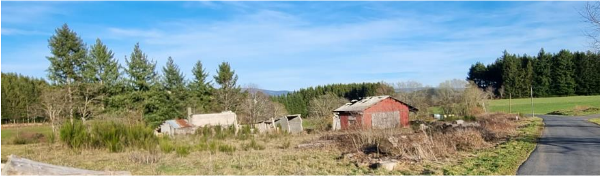
Vue depuis la RD sur les bâtiments de la scierie, après sinistre
