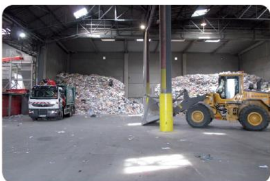
Quai de déchargement
