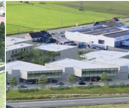
Exemple de Business Park
