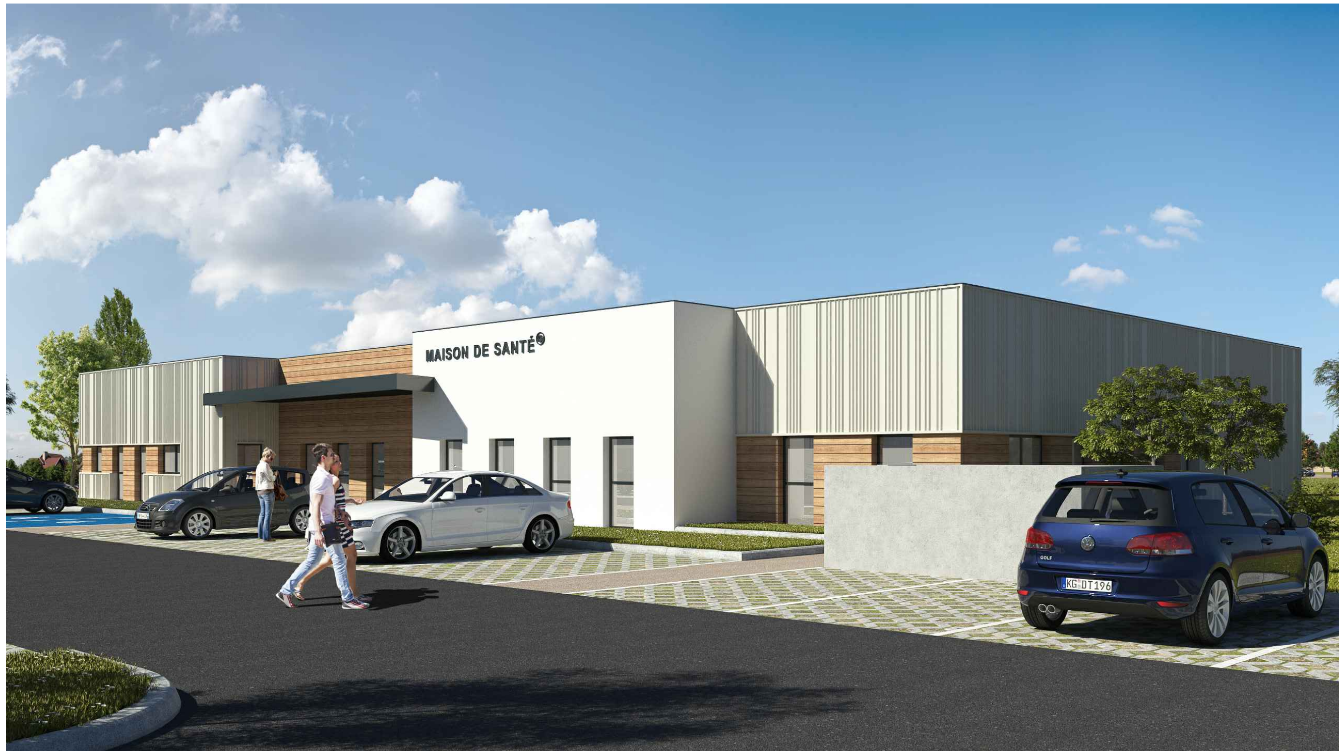
VUE SUR LA MAISON DE SANTE
