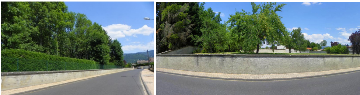
Vues Sud du site, depuis l'Avenue de la Gerle
