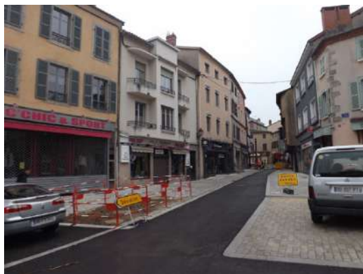
Vue sur la rue de la République depuis la place Saint-Jean
