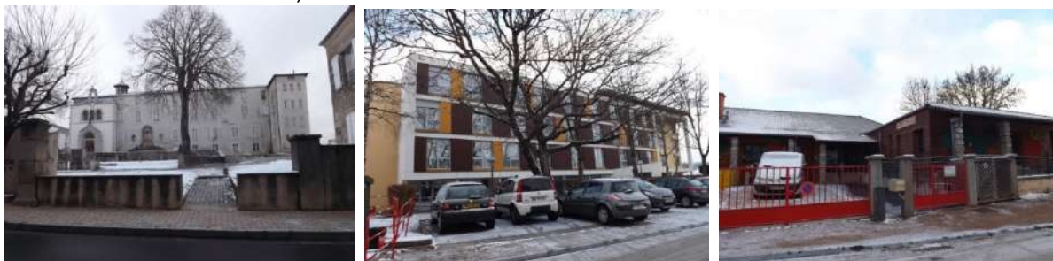
Centre hospitalier, centre Pré-Bayle et crèche municipale au nord du centre-ville
