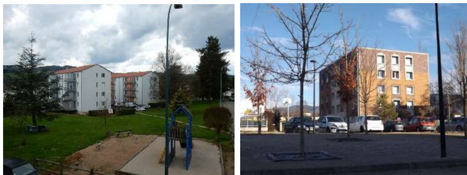
Résidence la Masse et résidence Villeneuve (OPHIS)
