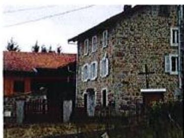
Façade décrépie, joints en creux qui mettent la pierre en apparence et la détournent dans ses irrégularités : une texture confuse où les pierres d'angles sont diluées
