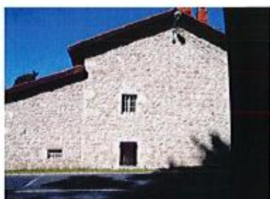
Joints lissés et sablés, effet d'unité
