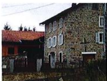
Façade décrépie, joints en creux qui mettent la pierre en apparence et la détournent dans ses irrégularités : une texture confuse où les pierres d'angles sont diluées
