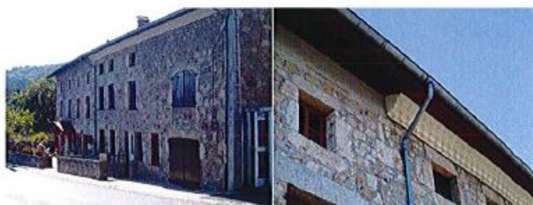
Exemple de fausse génoise préfabriquée et rapportée sur la façade : l'effet, la couleur le rôle sont très différents d'une génoise d'origine, faite avec des tuiles rondes.
