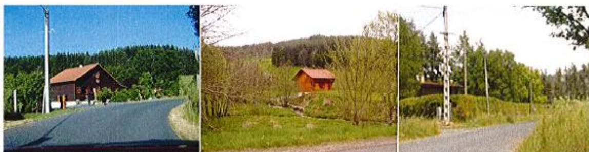
Des constructions bois de type « Chalet » savoyard
