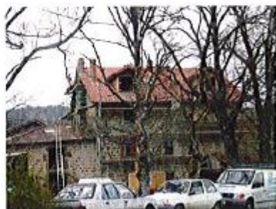
Un exemple quasi unique de lucarnes sur une réhabilitation
