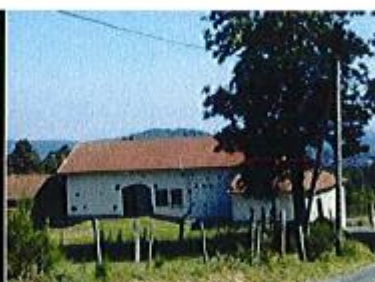
crêpis mono couche épais. Les boutisses ont été ressorties, un côté « anecdotique » à la façade
