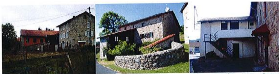
Deux réponses identiques à la même question : convertir le bâtiment en retour perpendiculaires (atelier + séchoir) en pièces d'habitation. Ici on répond en gardant le pignon extérieur en pierre et en fermant en bois : la lecture de l'architecture est préservée et les matériaux s'harmonisent.
