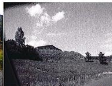
La construction de bâtiments de grande taille dans des terrains en pente impose des terrassements déblais/ remblais. En vue rapprochées on voit davantage le talus que le bâtiment. Le traitement du talus s'impose donc de manière simple et « naturelle » (semis de genêt par exemple ici, ou dynamique naturelle avec sélection des végétaux)
