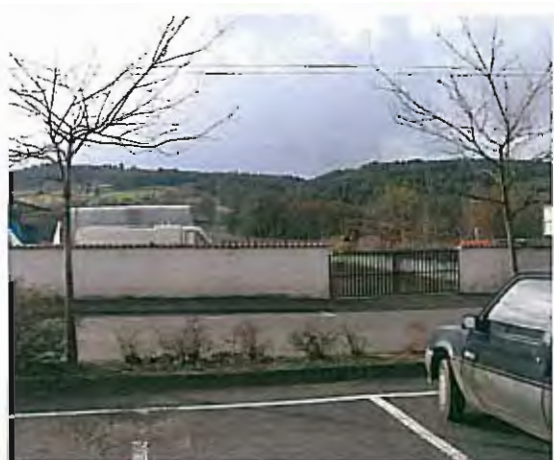
Le site borde la RD 906 à l'entrée Nord du bourg d'Arlanc
