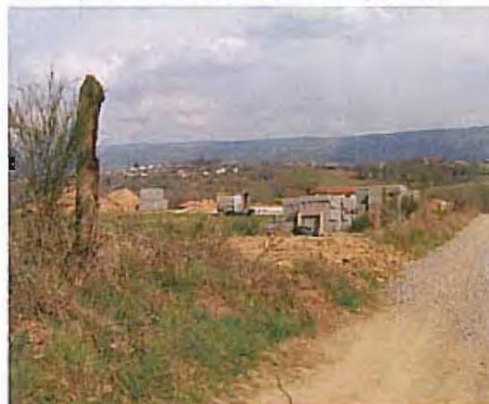
Construction en cours sur la parcelle voisine
