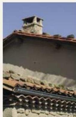
Les pentes d'origine doivent être conservées dans le cas d'une réfection de toiture.
