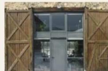
*Le choix de matériaux plus contemporains est bien sûr possible. La teinte est importante et l'on évitera les couleurs claires. Les menuiseries en aluminium laqué gris sont ici bien adaptées, et les portes de grange permettent de sécuriser l'ouverture. L'épaisseur de la dalle de l'étage est dissimulée en façade par la menuiserie.*
