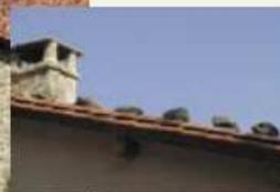
Les rives de toit en pignon seront traitées par un simple débord de tuiles creuses courantes. Les tuiles à rabat, les ouvrages de zinguerie sont à éviter.
