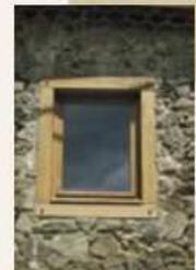
*L'encadrement est affirmé visuellement par un linteau traditionnel. La maçonnerie de pierre peut être conservée en l'état.*
