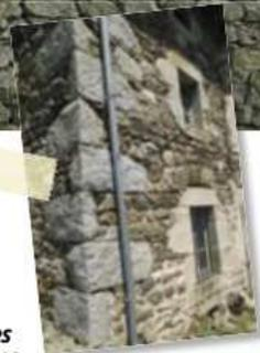
**Les pierres granitiques,** les plus résistantes sont utilisées pour les chaînages d'angle, les encadrements d'ouverture : linteaux, jambages...
