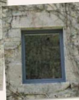
L'aluminium peint, l'acier, sont aussi envisageables en réhabilitation et permettent d'avoir des menuiseries de section inférieure.
