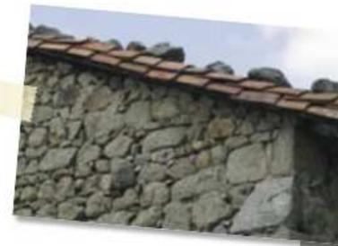
La rive de toit peut également être traitée par un débord de tuiles creuses courantes.
