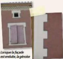
Lorsque la façade est enduite, la génoise est intégrée au bandeau de toit.
