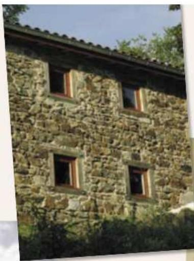
*En réhabilitation il est préférable d'éviter les ouvertures horizontales d'un seul tenant, souvent incompatibles avec la composition des façades. Jumeler deux fenêtres verticales classiques offre la même surface vitrée et facilite l'intégration dans la façade.*
