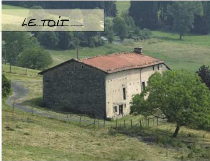
Des tuiles creuses en terre cuite rouge sont utilisées en couverture, maintenues par des pierres sur les ouvrages plus sensibles au vent : le faitage, les bords de toit.
