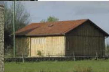
Construite dans les environs de Thiers, cette construction récente utilise le mur de la limite Nord de la parcelle comme soubassement, libérant ainsi un maximum de terrain au sud. L'utilisation du bois a simplifié la mise en œuvre du chantier sur un site escarpé difficilement accessible. Le bardage de larges planches brutes n'est pas sans rappeler les petites dépendances construites dans la région thiernoise.
