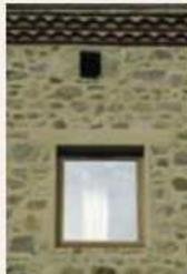
*L'encadrement en béton est enduit soigneusement. Il disparaît dans la maçonnerie rejointoyée.*
