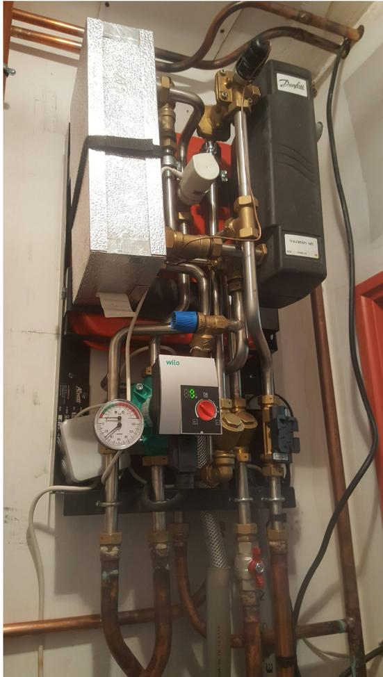
→ Correction à apporter / Action N° 5 : Vérifier le manomètre et le vase d'expansion par le constructeur et les remplacer si besoin.
