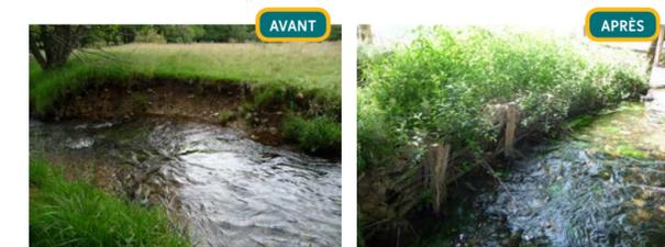
Ci-dessus, un tressage réalisé sur le ruisseau de l'Enfer permettant de restaurer une zone d'érosion dans un virage. Ici, les saules qui constituent le tressage, se sont développés et permettent le maintien de la berge en rive droite du ruisseau.
